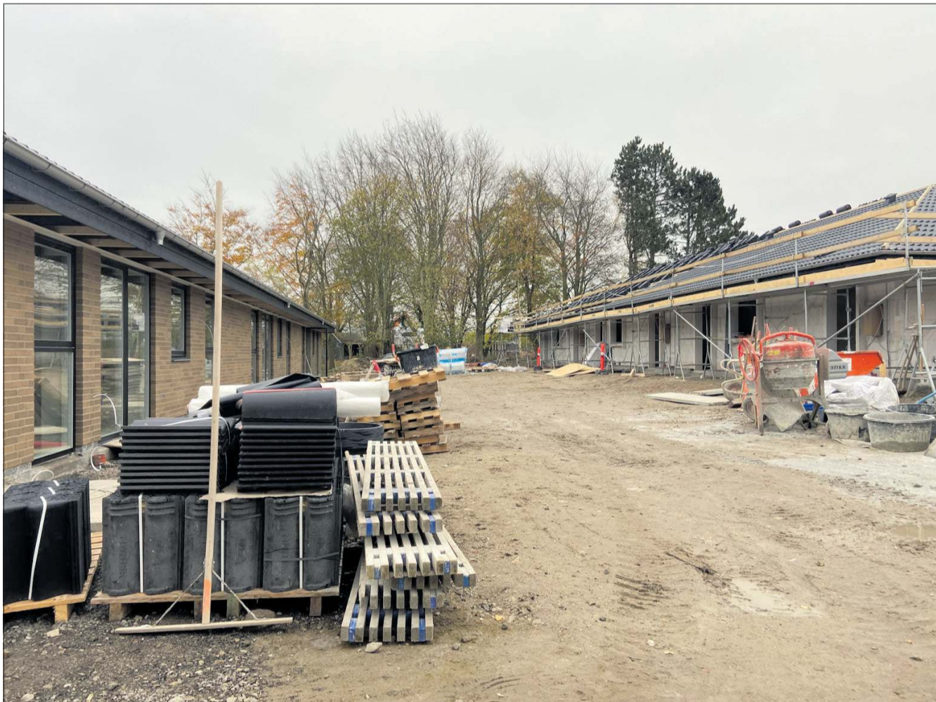
Byggeriet af Golfhaven i Gammel Rønnede er godt på vej, som man kan se her på avisens billede, der er taget forrige søndag. Men der bliver først indflytning i september 2023, når alle 32 rækkehuse er bygget, og de udendørs anlæg er på plads. Foto: Nikolaj Rasch Skou
